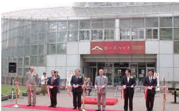
会場の温室施設「ローズハット」
